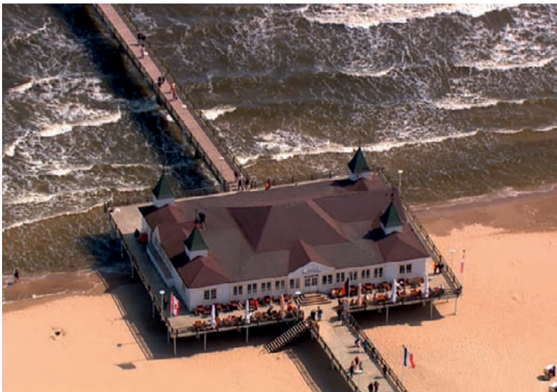
----- Seebrücke im Kaiserbad Ahlbeck
